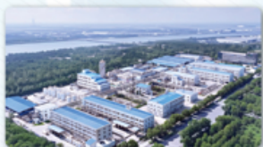
天津汉沽基地 TIANJIN HANGU
